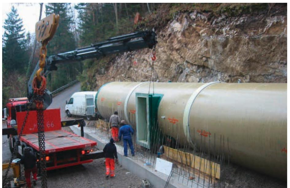
Versetzen des Fertigteilhochbehälters Mühlgraben - Inhalt = 100.000 Liter
